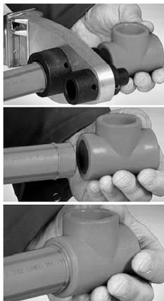
5 Аккуратно извлеките трубу и фитинг из сварочного аппарата и вставьте трубу в фитинг. При стыковке не рекомендуется вращать их относительно друг-друга. Для обеспечения необходимой точности (угловые фитинги) рекомендуется воспользоваться дополнительной оснасткой.
