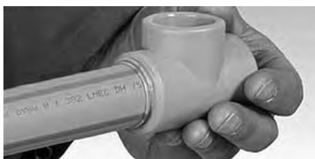
Во время обработки соединенные элементы должны быть зафиксированы. В это время соединение можно откорректировать.
