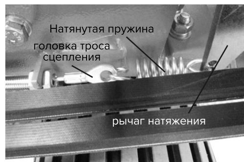
Проверка пружины натяжения
